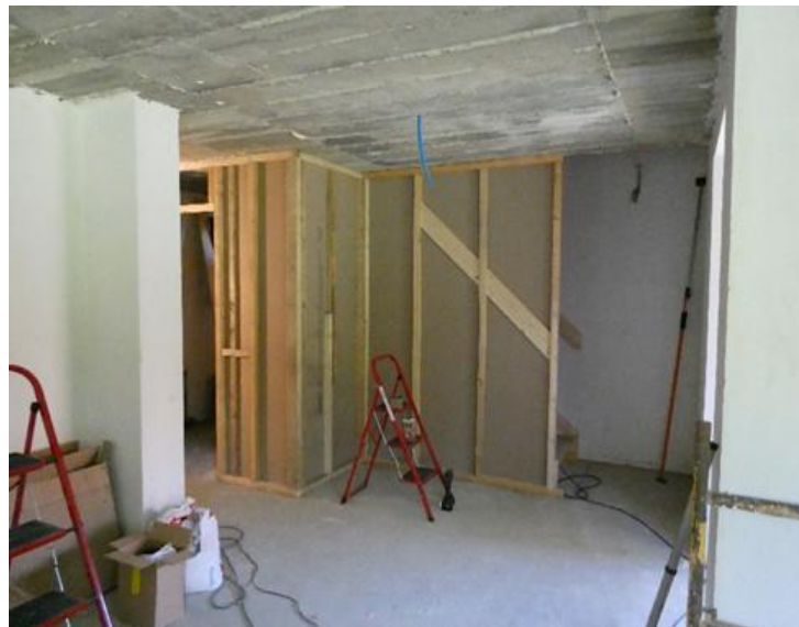
Wand vom Eingang zur Treppe und zum Technikraum
