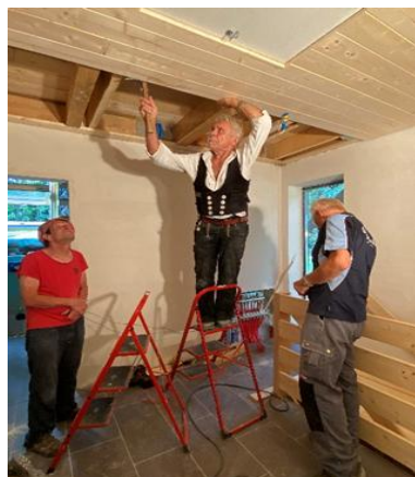
Anschrauben der Querlatten an der Decke
