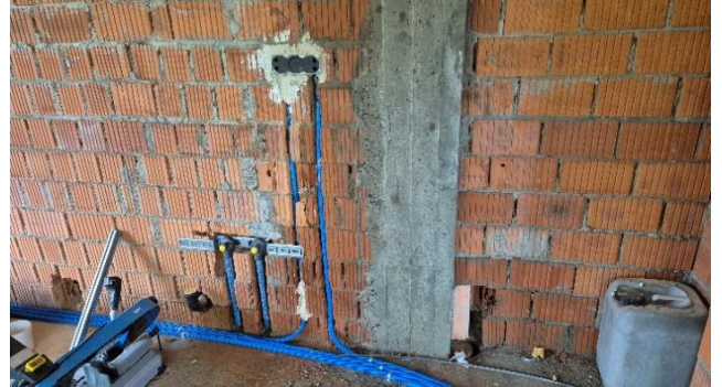
Mauern und Decken durchbohren und Schlitze für Elektro- und Wasserleitungen fräsen
