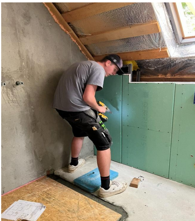
Lion beginnt die GIS-Vorwand mit Gipspaneelen zu beplanken
