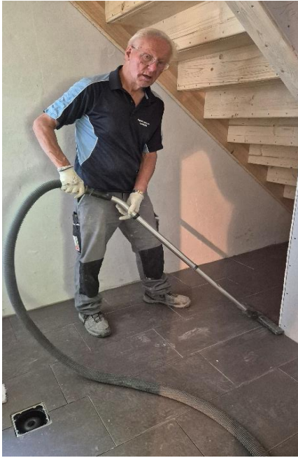
Vor dem Ausfugen reinigt Leo alles
