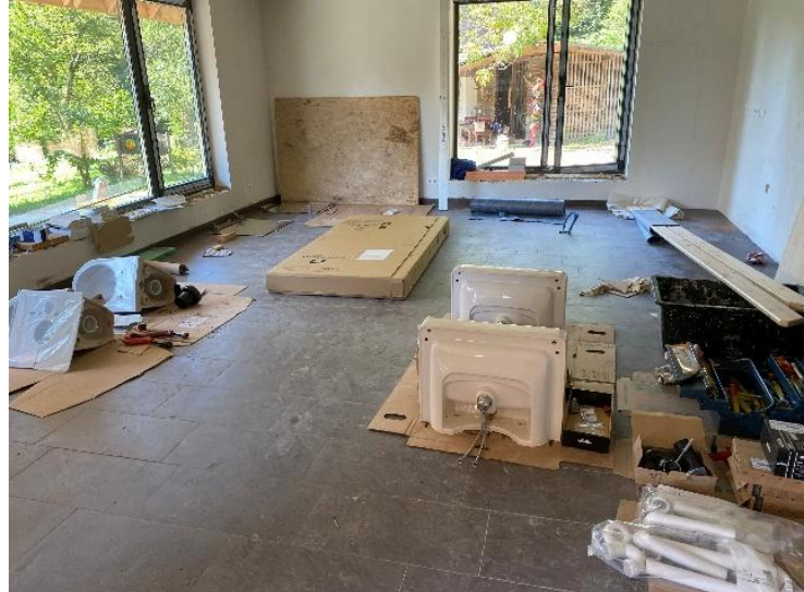
Vorbereitung zur Waschtisch und Trennwand-Montage
