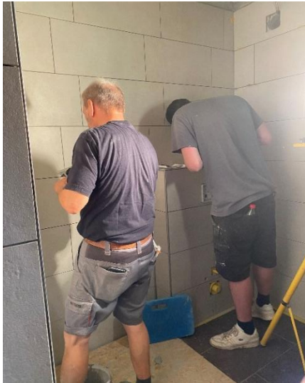
Ivo und Lion reinigen die Fugen
