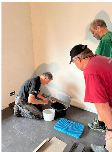
Roland, Ivo und Josef wird gezeigt, wie man die Sockelplatten am besten anbringt
