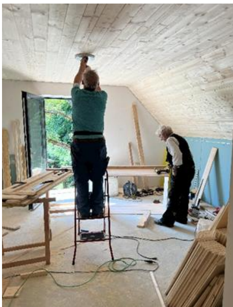
Die ersten Lampen werden montiert
