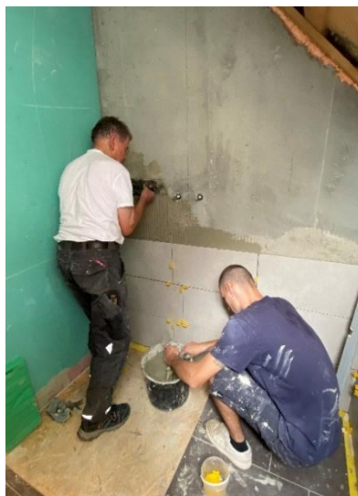
Die grosse Herausforderung sind hier die Ecken und die Aussparungen für die Apparate-Anschlüsse
