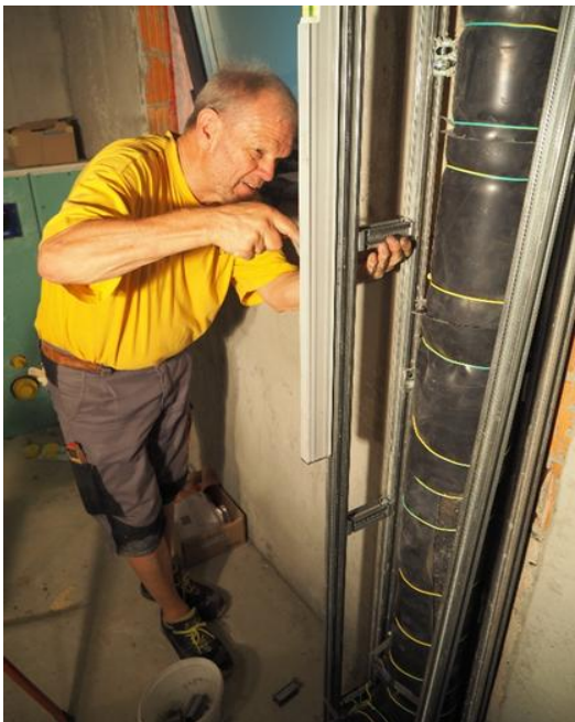
Ivo verkleidet die Abwasser-Falleitung
