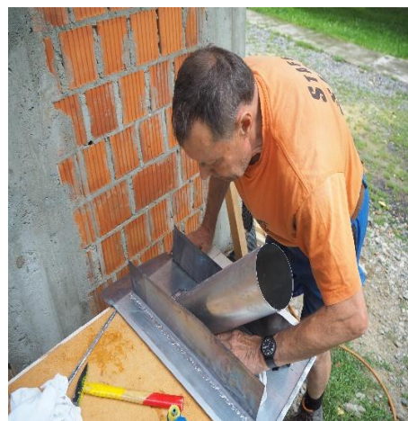
Franz beim Herstellen und montieren der Dunststohreinfassung
