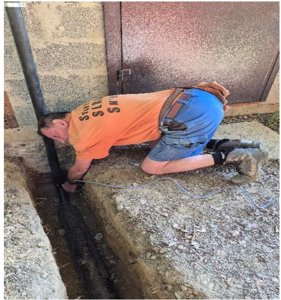
Franz verlegt die Elektro-Hauptleitung mit Schutzrohr im Graben vom Neubau zur Zentrale
