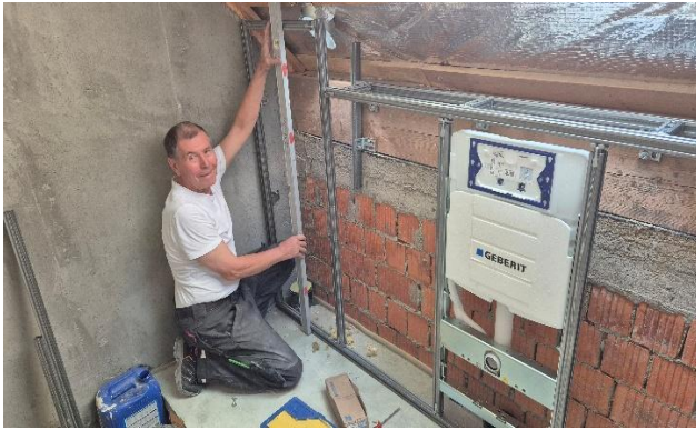
Edi beim Einbau der GIS Vorwandinstallationen mit den UP-Spülkästen im OG
