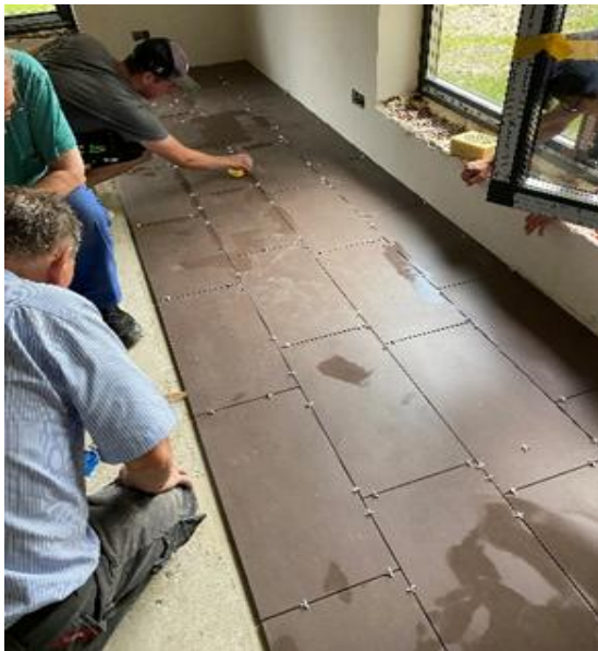
Erste Keramikplatten sauber verlegen
