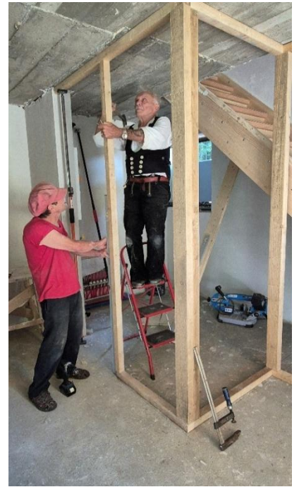
Wandaufbau zum Technikraum
