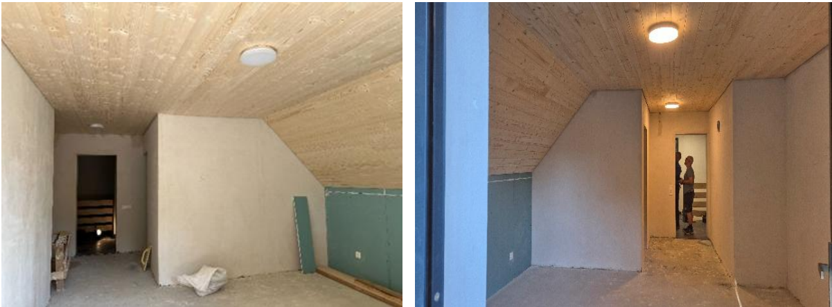
und Blick gegen Osten Richtung Vorplatz und Treppe
