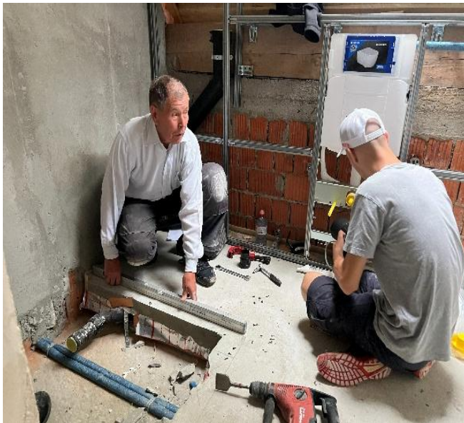
Edi + Janis beim Einbau der Duschwanne
