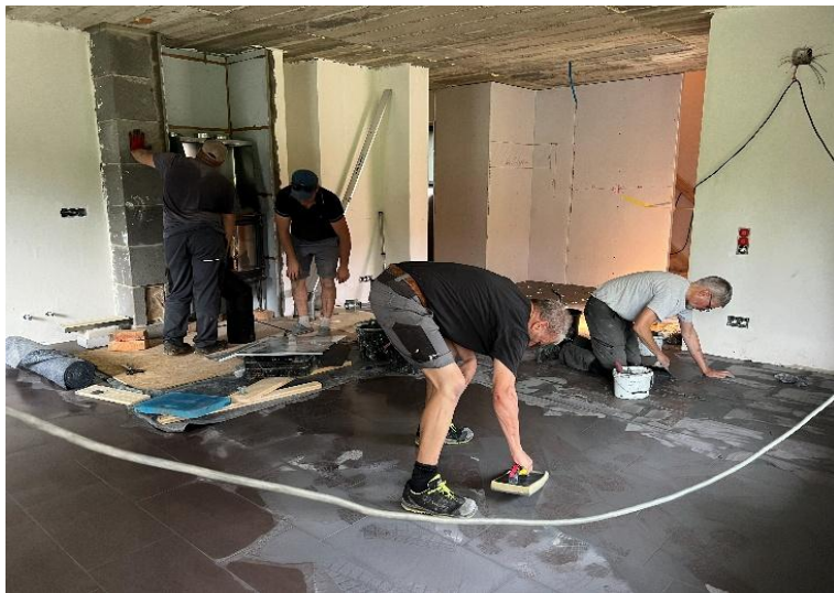
Vor dem Ausfugen reinigt Leo alles
