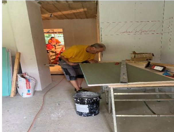
Gipsplatten zuschneiden für die senkrechten Wandverkleidungen in den Schlafzimmern
