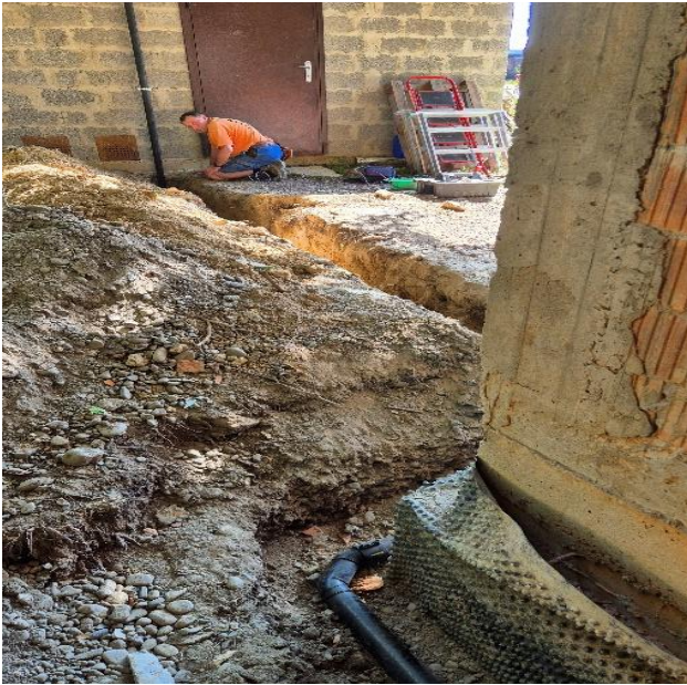
Franz verlegt die Elektro-Hauptleitung mit Schutzrohr im Graben vom Neubau zur Zentrale
