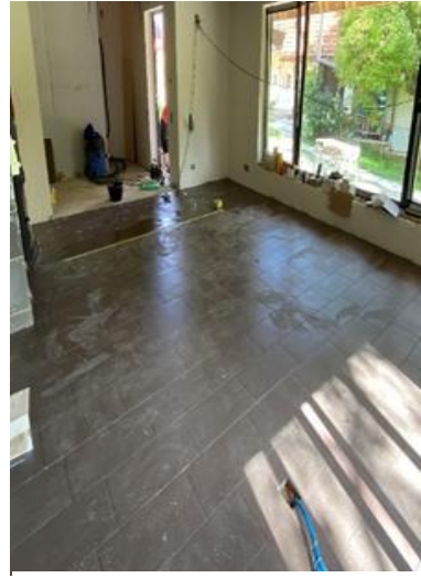
Muss nur noch ausgefugt werden
