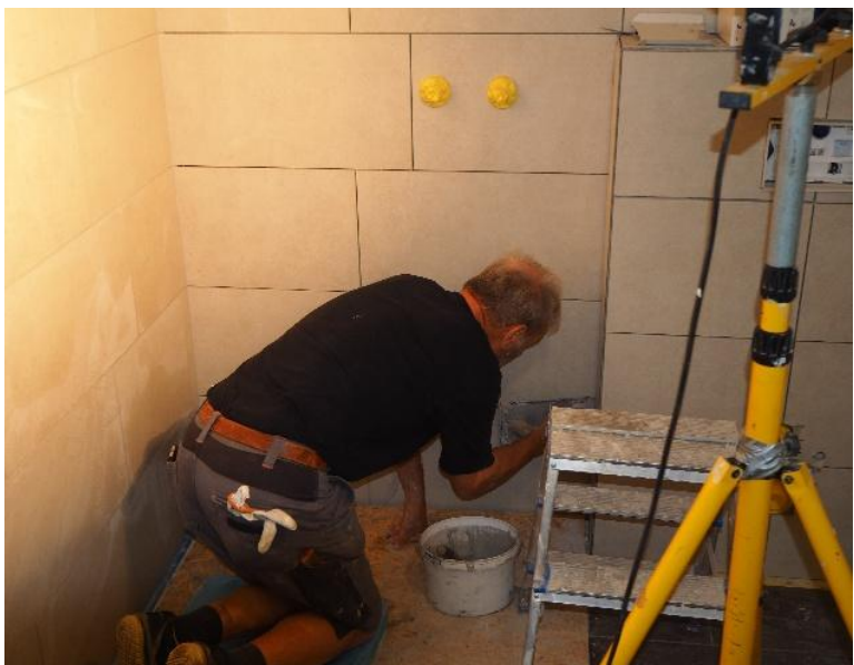
Ivo beginnt mit dem Ausfügen der Wandplatten
