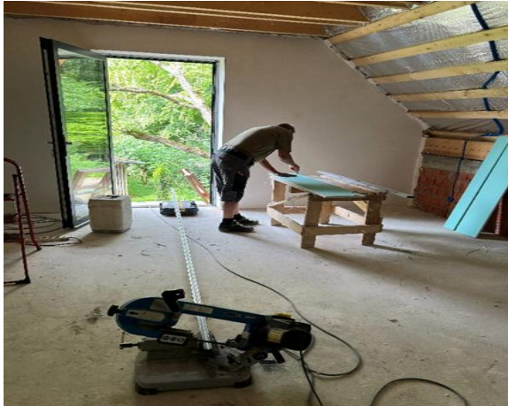
Gipsplatten zuschneiden für die senkrechten Wandverkleidungen in den Schlafzimmern
