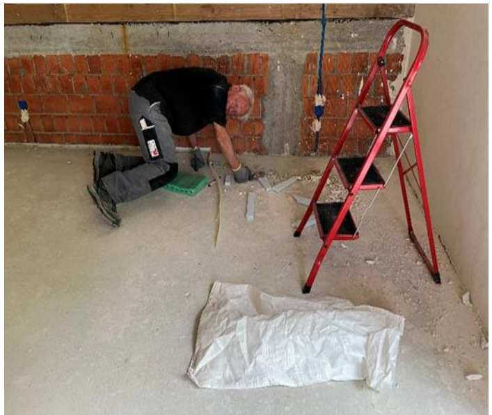
Leo beim Boden-Randstreifen entfernen
