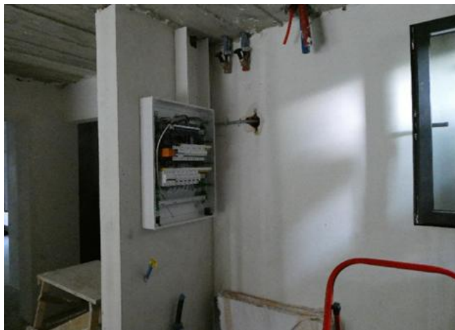
Boiler, Sanitär- und Heizungsverteiler werden später von den Ukrainern installiert.
