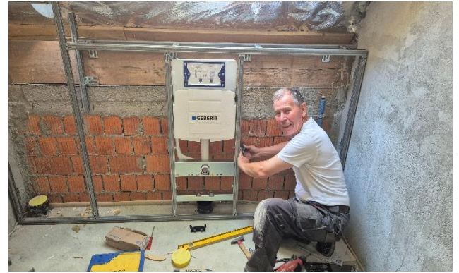
Edi beim Einbau der GIS Vorwandinstallationen mit den UP-Spülkästen im OG
