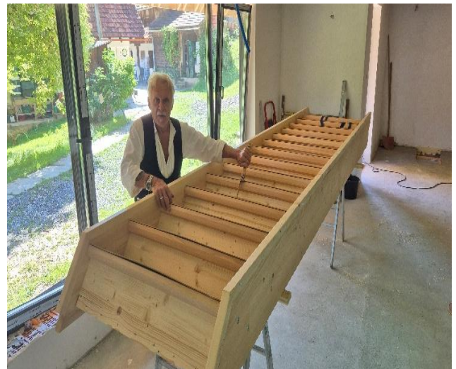
Ingo hat die Treppe wieder zusammengebaut....
