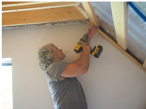
Anschrauben der Querlatten an der Decke
