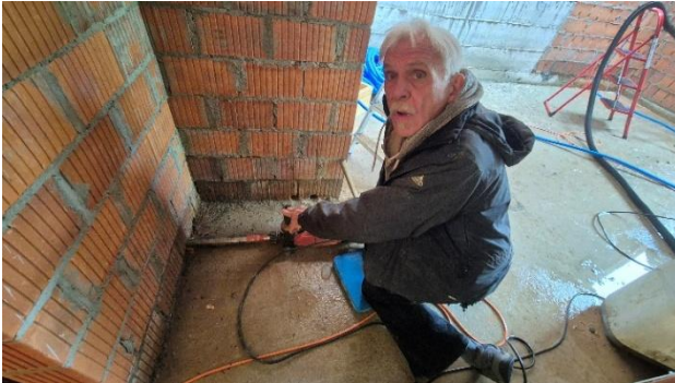
Mauern und Decken durchbohren und Schlitze für Elektro- und Wasserleitungen fräsen
