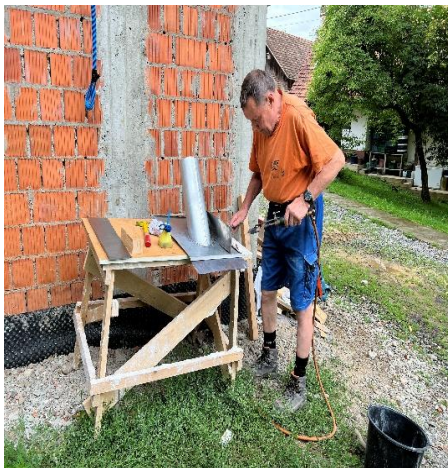
Franz beim Herstellen und montieren der Dunststohreinfassung
