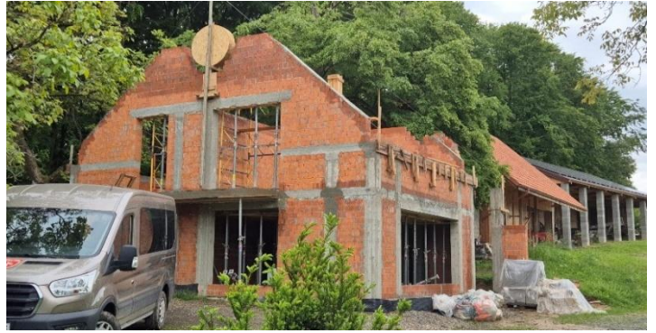
Rohbau: noch ohne Dach
