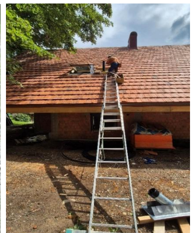
Franz beim Herstellen und montieren der Dunststohreinfassung
