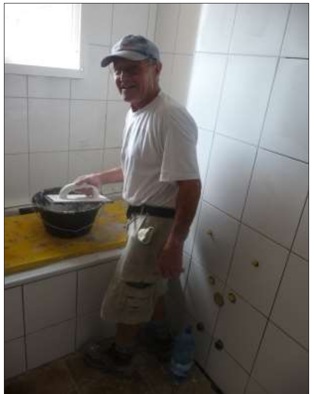
Das Ausfugen sieht einfach aus, benötigt aber viel Kraft und Fingerspitzengefühl.
