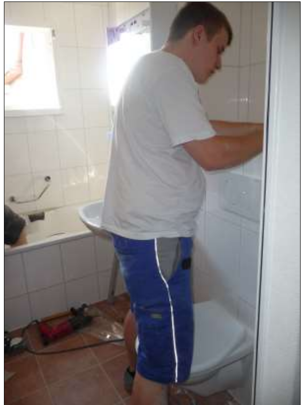
Flavio in seinem Element. Montage der Apparate, Armaturen und Garnituren.
