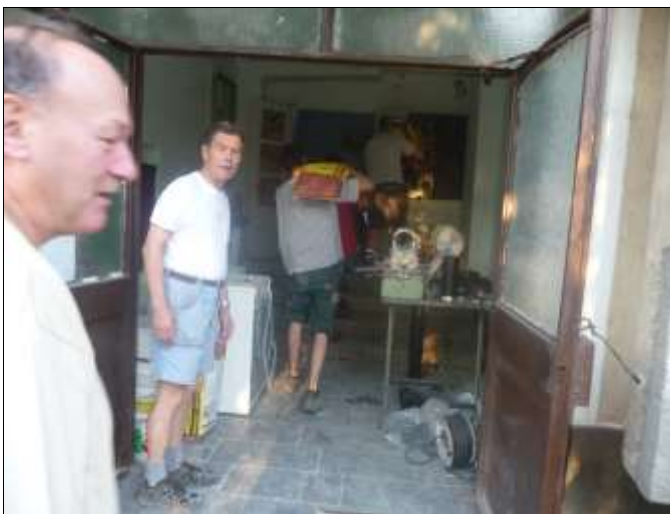
Ausgleichs- und Verputzmaterial wird in die Stockwerke verteilt.
