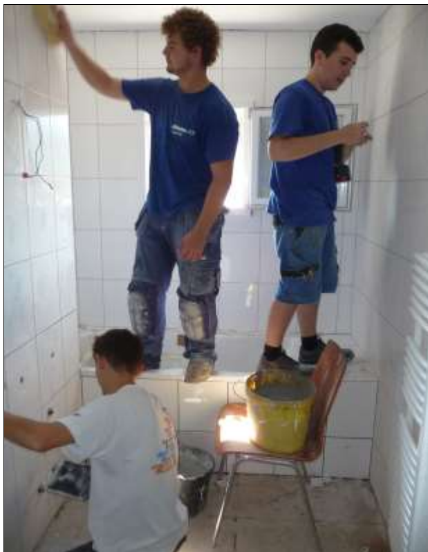
Mit Volldampf wird in allen zehn Badezimmern gearbeitet. Die beiden Dario's und Lechster beim Ausfugen.
