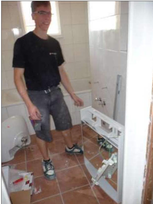
Zum „Dessert“ der riesigen Arbeiten kommt die Fertigmontage der Apparate. Mischa beim Setzen der tollen Schneider-Spiegelschränke.
