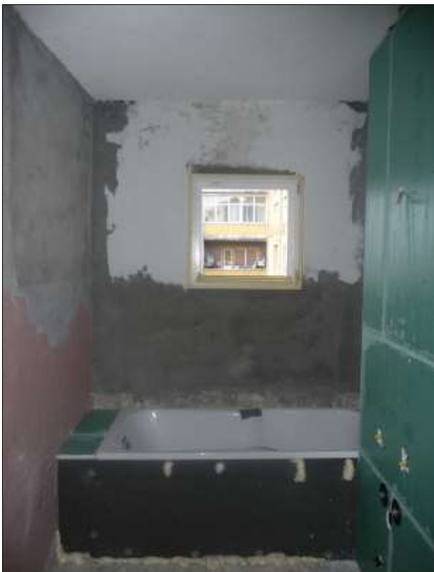
Die Badezimmer sind nun bereit für die Plättlarbeiten.
