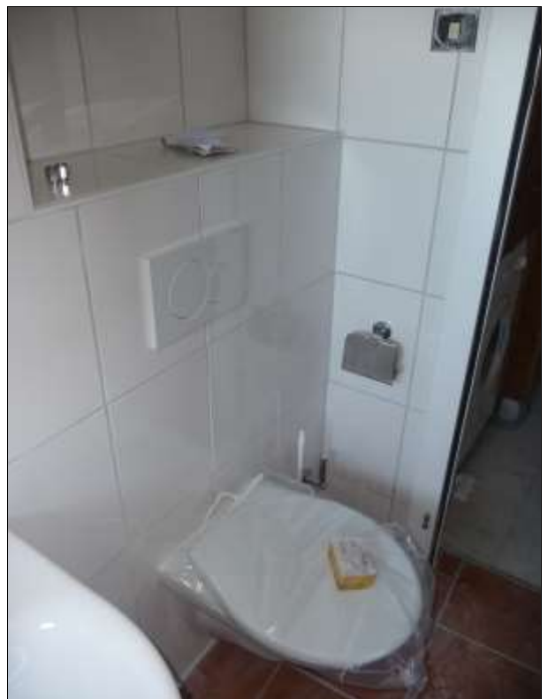
Unglaublich, was in elf Arbeitstagen geleistet wurde!
