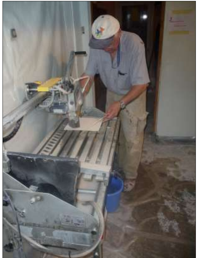
Für Millimeter genaues zuschneiden der Plättli ist, unter anderen, Charly zuständig.
