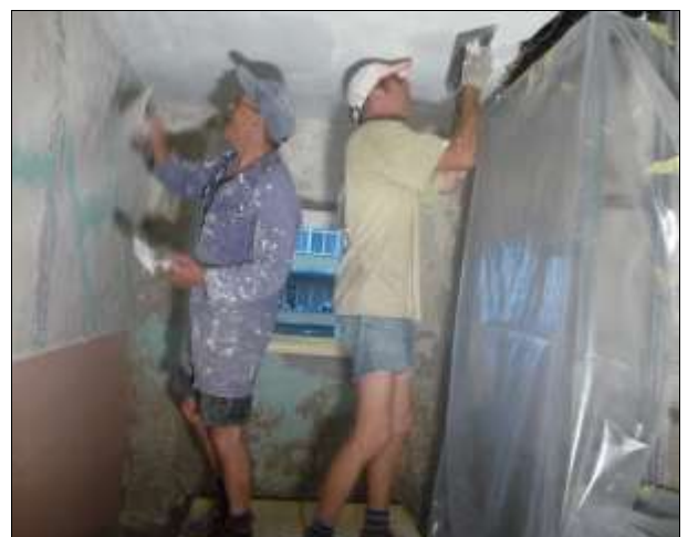
Othmar und Walter bei der sehr strengen und schweisstreibenden Arbeit für den Deckenabrieb.
