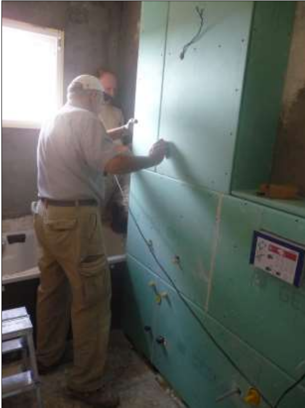
Die GIS-Wände sind mit imprägnierten Gipskartonplatten verkleidet worden, um dann die Keramikplatten darauf zu kleben.
