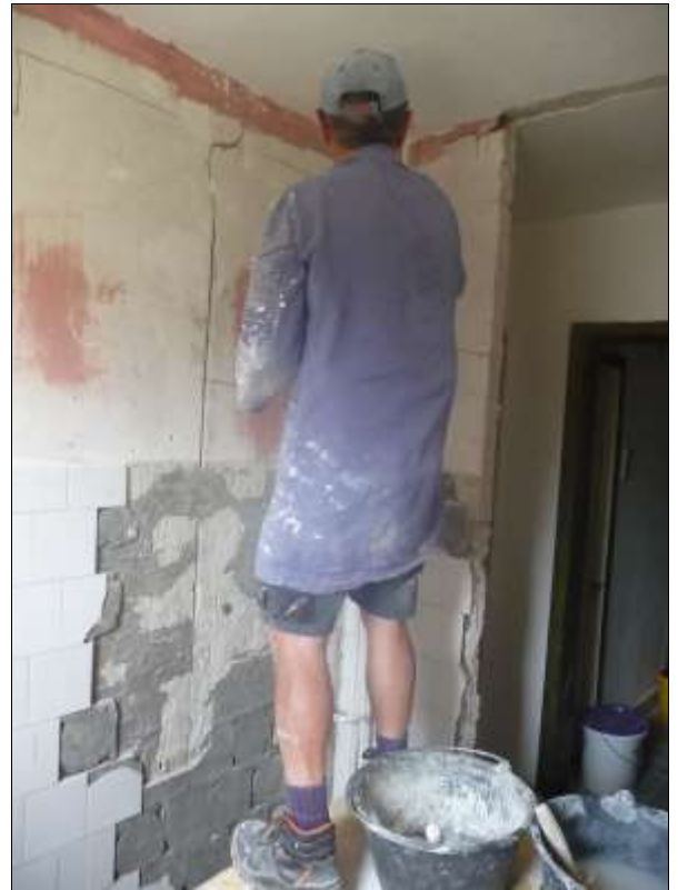
Walter Näf, unser Maurer, beim Ausbessern der kritischen Wände und Decken.
