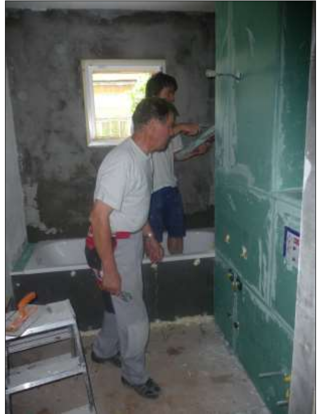
Sämtliche Fugen werden von Dominik mit Spachtelmasse ausgefüllt und alles von Edi genauestens inspiziert.
