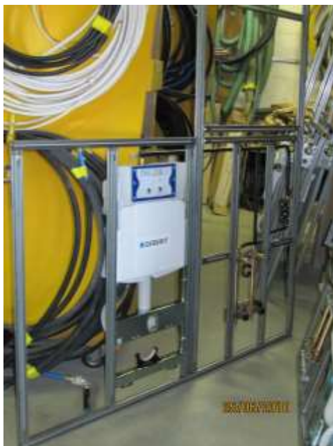
Vorfabrizierte GIS-Rahmen mit eingebautem Geberit-UP-Spülkasten, Abstellventilen und Mepla-Rohren.
