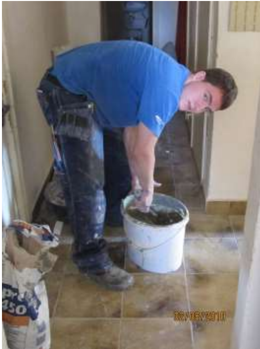
Heizungslehrling Kim Fehr hat die neuen Radiatoren montiert und angeschlossen und hilft nun beim Platten legen.
