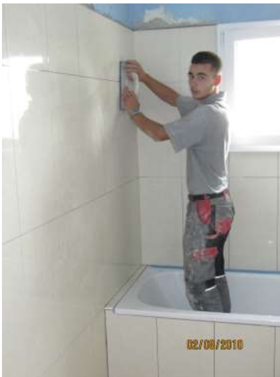
Die Keramikplatten sind sauber verlegt und Dejan Poplasen beginnt mit dem Ausfugen.
