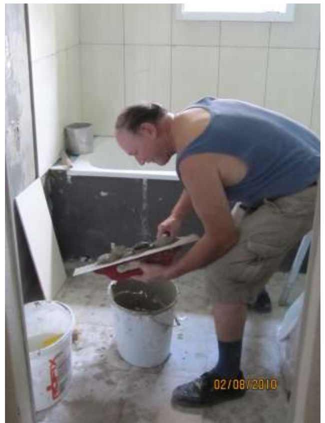
Ernst, der Alleskönner, hat schon das halbe Badezimmer fertig geplättelt.
