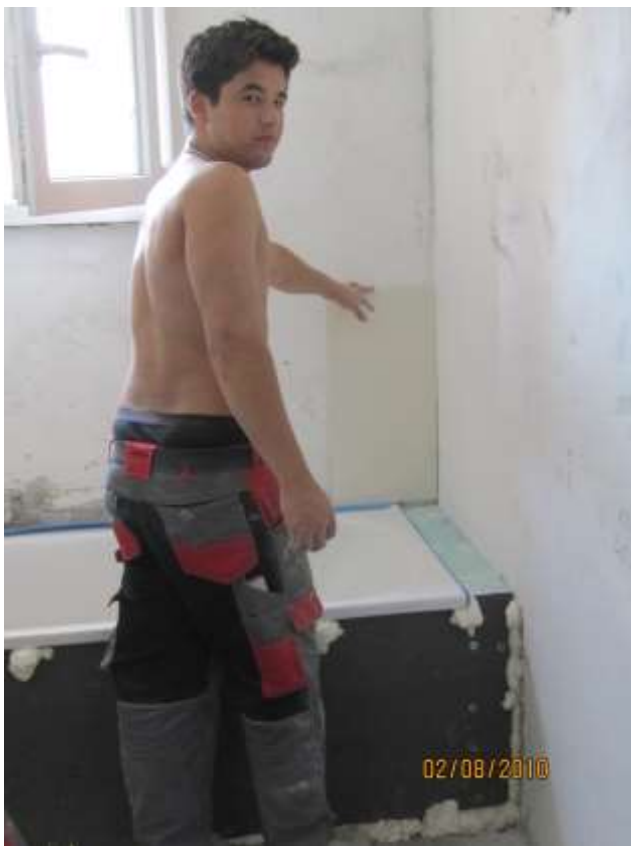
Mike Tanner brennt darauf mit den Platten-Arbeiten beginnen zu können.
