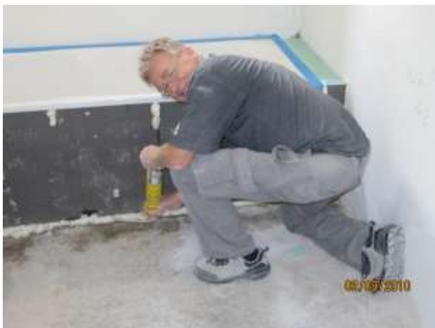
Durch Hanspeter Schilling wird die Platte hinter-schäumt und alle Schlitzte mit Bauschaum ausgefüllt.
