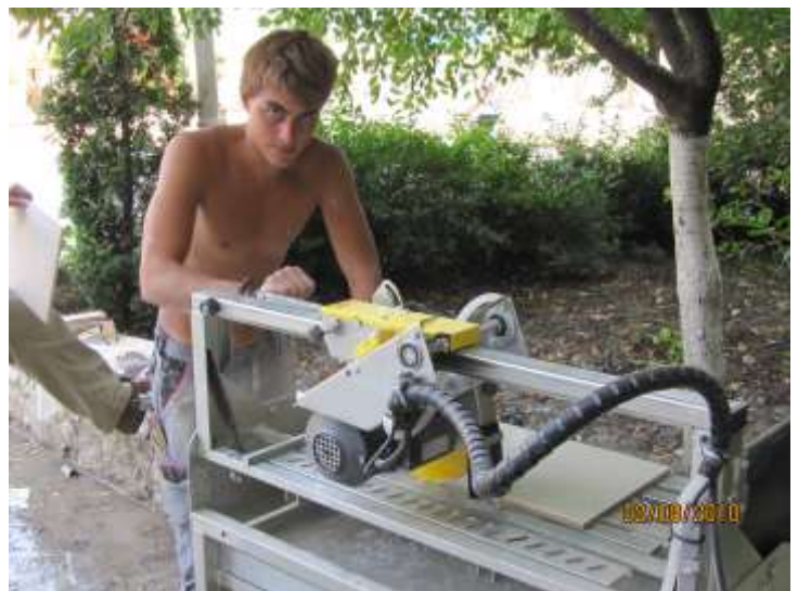
Florian Oertli beim massgenauen Zuschneiden der grossflächigen Keramikplatten.
