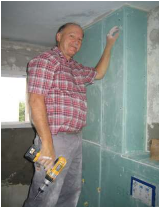
Ernst Scherrer beplankt die GIS-Wand mit 18 mm dicken Gipspaneelen, nachdem er alle Fenster montiert hat.
