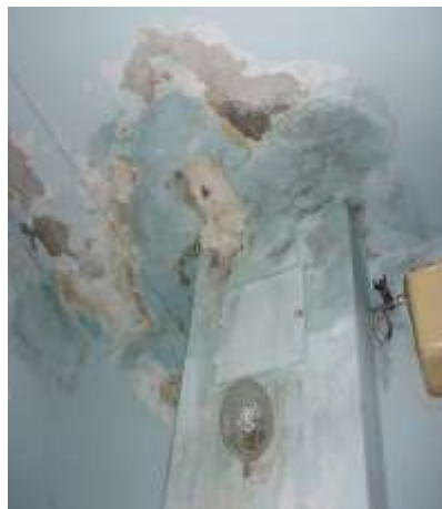
Feuchtes Mauerwerk
