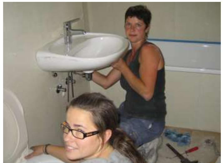
Die Sanitär-Fertigmontage kann beginnen. Silvia Rechsteiner und Nathalie montieren die Apparate, Armaturen und Garnituren gekonnt und mit grosser Sorgfalt.
