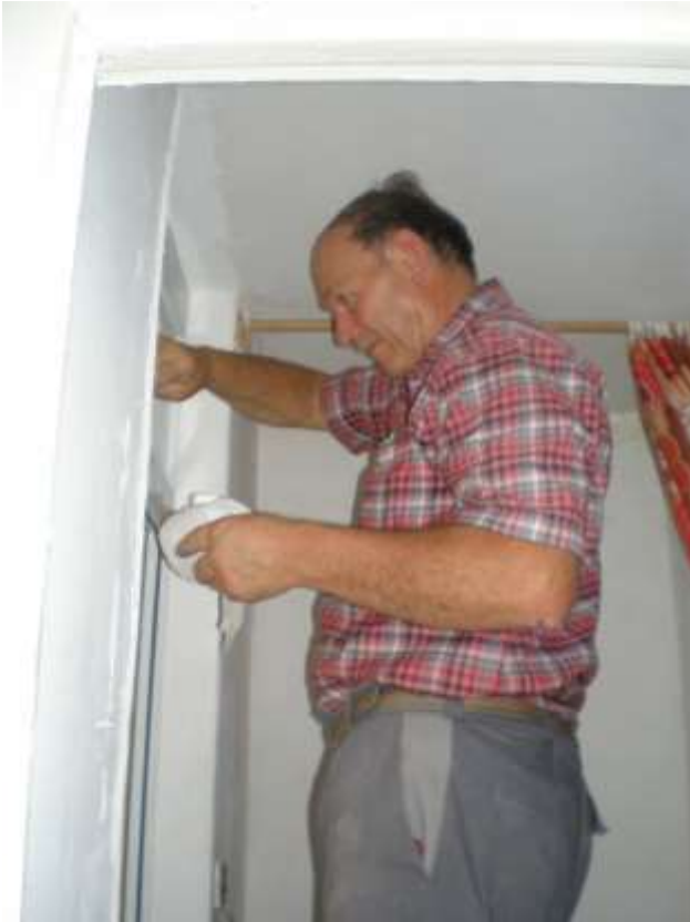
Höchste Konzentration von Ernst Scherrer beim Einbau der neuen Türrahmen.
