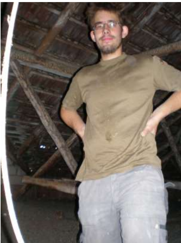
Gian-Rico Knecht hat soeben die Lüftungsleitungen in den Estrich geführt.
