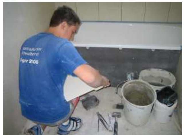
Der Vollprofi, Marcel Schildknecht, kann bereits mit dem Verkleiden des ersten Bades mit wunderschönen . Keramikplatten beginnen.
