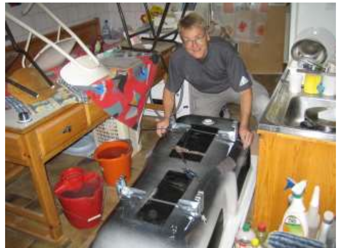
Einbau der vorfabrizierten GIS-Elemente und verbinden der Wasser- und Ableitungen.
