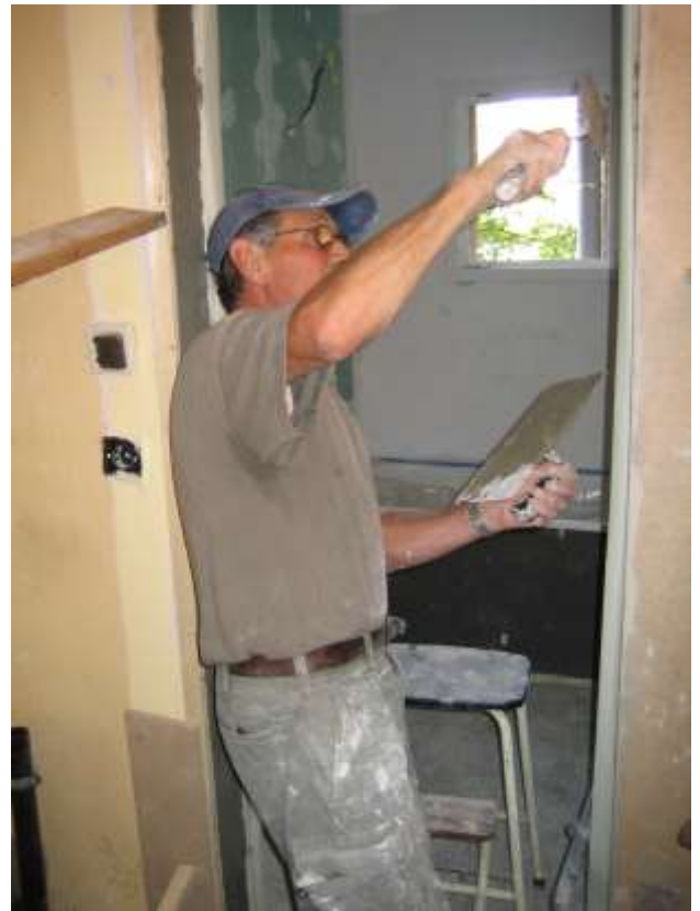
Für spezielle Maurerarbeiten ist Walter Näf zuständig. Hier beim Verputzen der Türleibungen.
